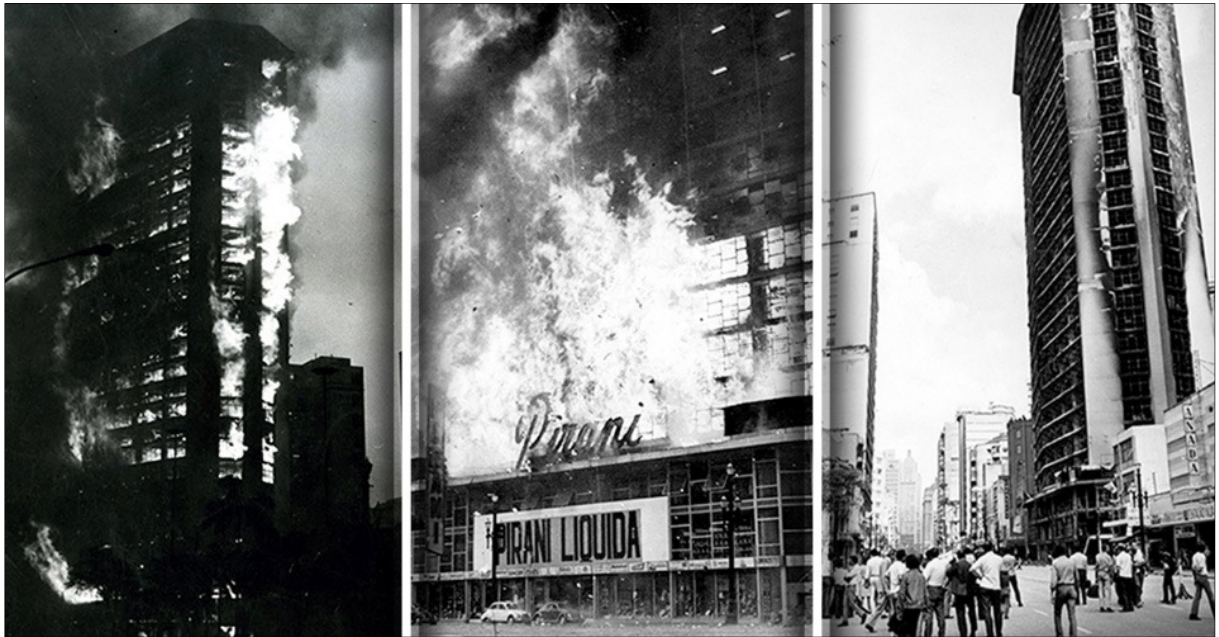
Figura 3 - Incêndio no Edifício Andraus em 1972
