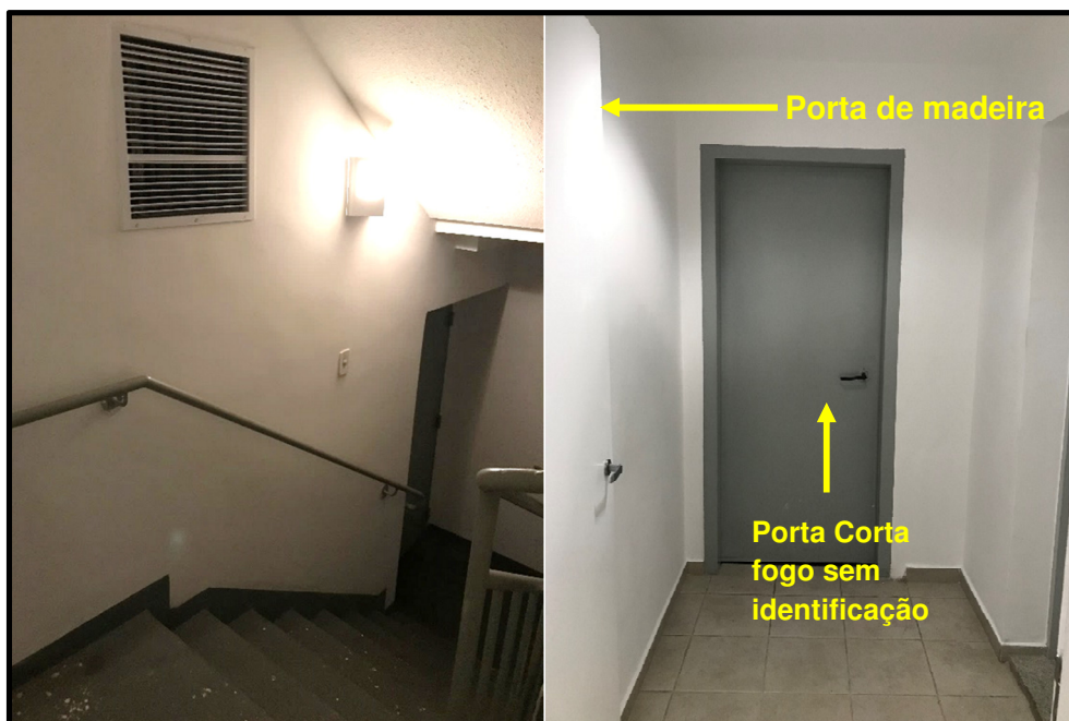
Figura 12 - Saídas de emergência
